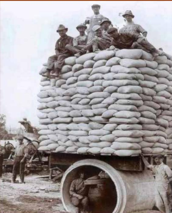
**Проверка прочности трубы.
